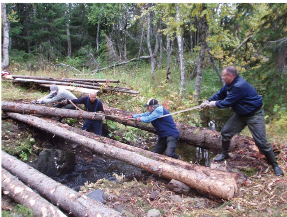
Uno Johansson, Roland Berglund, Mats Wiberg och Lars Persson spänner musklerna under broreparation i september.
